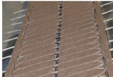
Construcción de un tramo de ensayo de hormigón y detalles de los bucles de inducción
