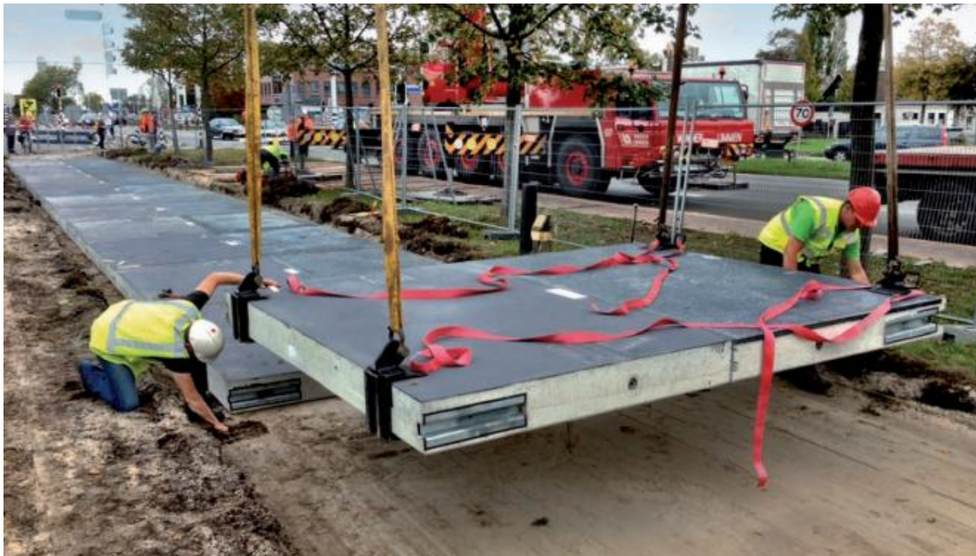
PROYECTO SOLAROAD (TNO) DE ENERGY HARVESTING SOBRE UN PAVIMENTO DE HORMIGÓN DURABLE
