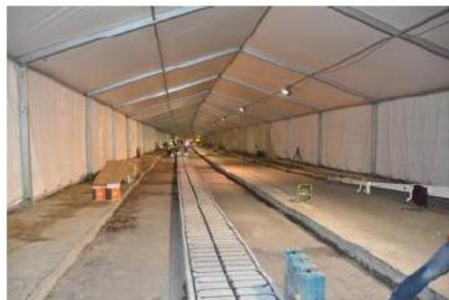
Construcción de un tramo de ensayo de hormigón y detalles de los bucles de inducción
