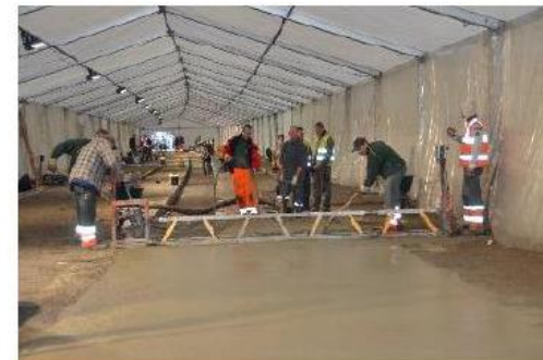
Construcción de un tramo de ensayo de hormigón y detalles de los bucles de inducción
